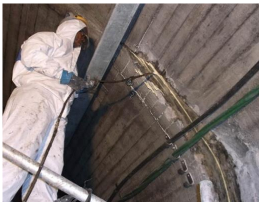
Figura 51 - Injecção de resina de poliuretano (fotografia fornecida pela HTecnic)
