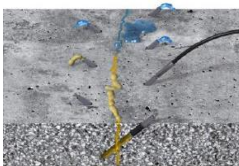
Figura 45 - Injecção de resina de espuma de poliuretano com injectores mecânicos [15]
