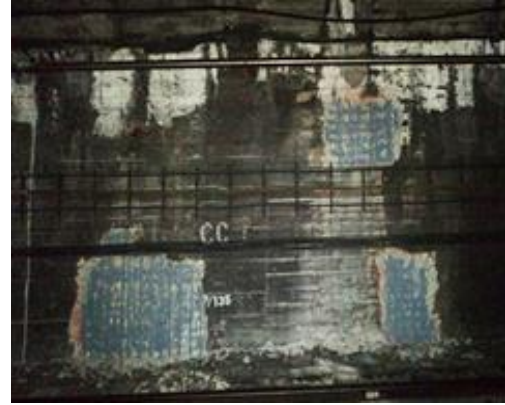
Figura 56 - Armaduras protegidas com inibidor de corrosão (fotografia fornecida pela HTecnic)
