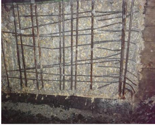
Figura 55 - Zona a reparar com armaduras tratadas (fotografia fornecida pela HTecnic)
