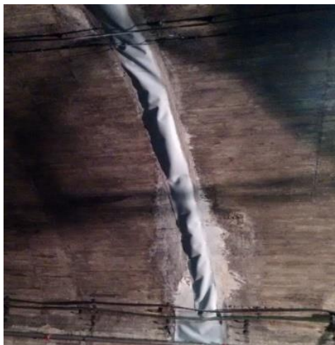
Figura 58 - Banda elástica aplicada sobre junta de dilatação
