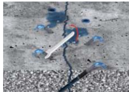
Figura 44 - Aplicação e aperto dos injectores mecânicos [15]
