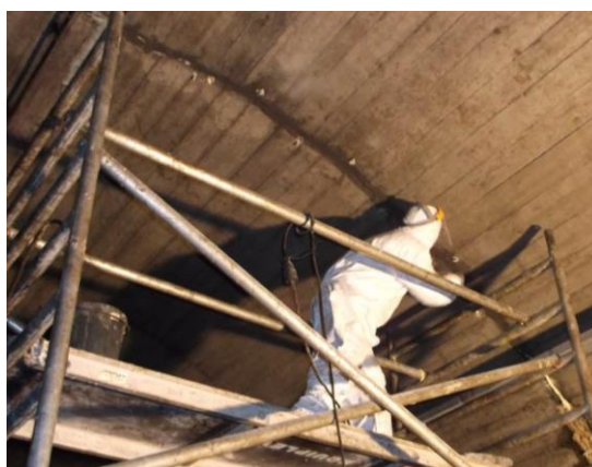
Figura 49 - Colocação dos injectores após furação (fotografia fornecida pela HTecnic)
