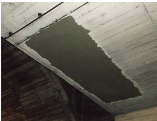
Figura 57 - Reparação do betão com argamassa tixotrópica (fotografia fornecida pela HTecnic)
