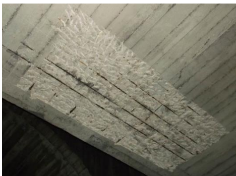
Figura 54 - Área de reparação após tratamento e limpeza da superfície (fotografia fornecida pela HTecnic)
